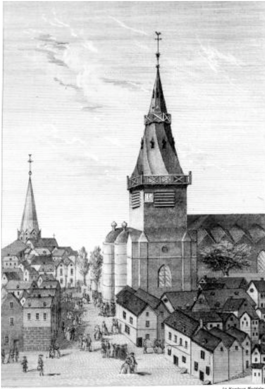
A Eglise de S t Pierre. 1740. B Eglise du Prieuré. C Hôtel de la Tournelle. D Hôtel-Dieu.
